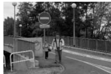
Photo 19 - Passerelle mixte vélos-piétons
